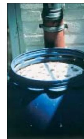
Gesehen am Institut in Oberursel: Regenwassertonne an einem sonnigen Platz mit großflächigem Schwimmer aus Styropor.
